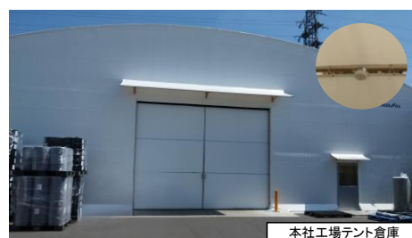
本社工場テント倉庫
